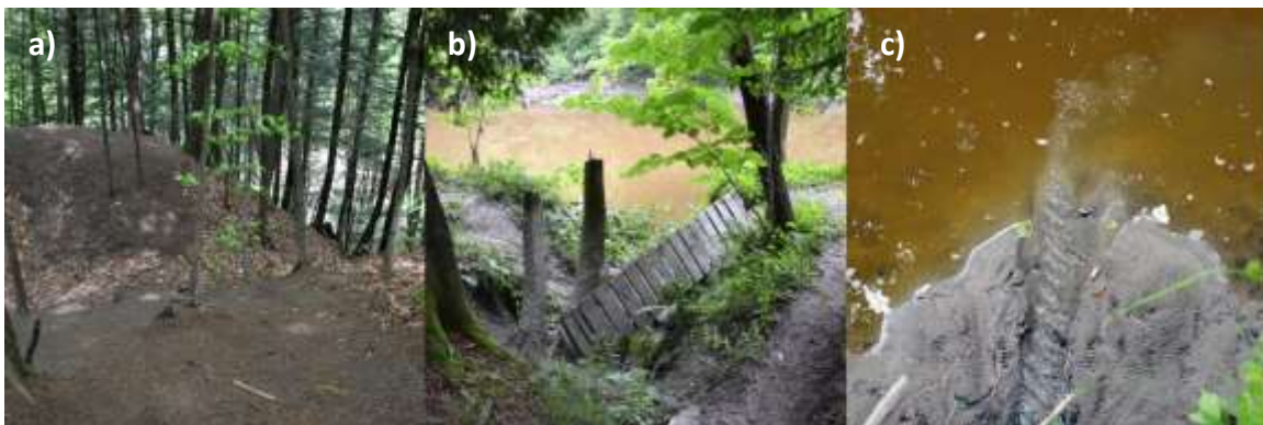
Figure 41. Portions de sentiers susceptibles d'entraîner des sédiments dans les cours d'eau. a) Sentier L'Intense, où le piétinement a mis à nu le sol et où on devine le ruisseau Quévillon-Robert en contrebas; b) Sentier qui borde la rivière Mascouche, dans le secteur nord-ouest du Parc, où un pont improvisé a été renversé; c) sédiments se jettant dans la rivière Mascouche à la suite de l'érosion du sentier.
