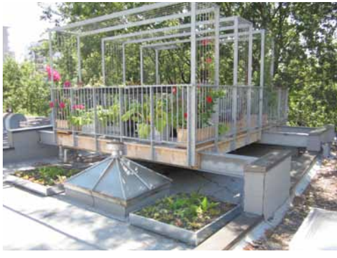
Toit-terrace de l'immeuble du Centre d'écologie urbaine de Montréal, à Montréal.
