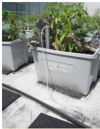
Système d'irrigation goutte à goutte connecté avec la réserve d'eau d'un bac Alternatives.
