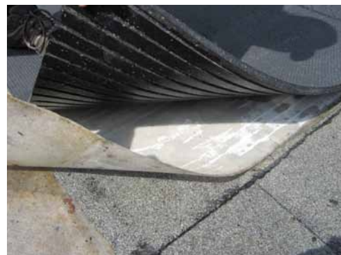
Protection de géotextile et de tapis de caoutchouc sur toiture d'élastomère.
