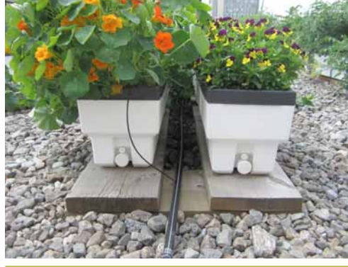
Protection en bois sur toiture inversée.
