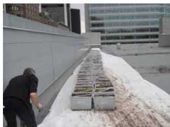
Déplacer les bacs à l'endroit où la capacité portante du toit le permet.
