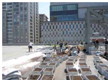
Mélange du terreau et remplissage des bacs.
