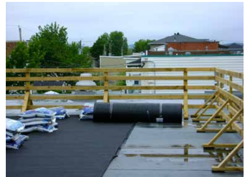
Protection en panneau de drainage (Sopradrain 10G) sur membrane élastomère. Crédit : Les Urbainculteurs
